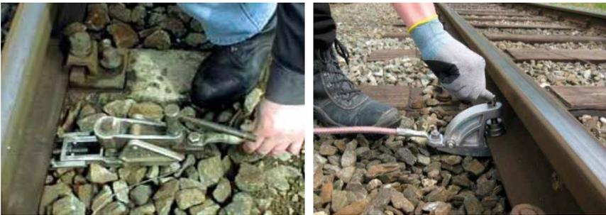
*Abbildungen 20a und 20b: Befestigen der Schienenfußerdungsklemme*
