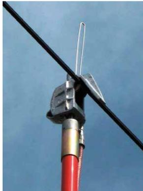
Abbildung 23: Einhängen der Fahrdrahterdungsklemme
