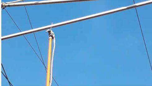
Abbildung 22: Feststellen der Spannungsfreiheit mit Prüfspitze
