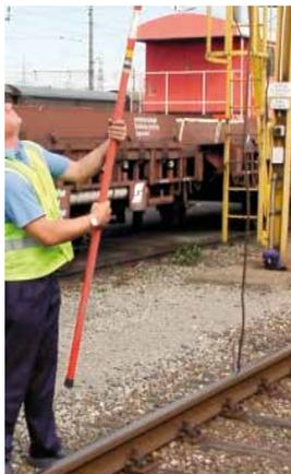
*Abbildung 21: Aufrichten der Erdungsstange*
