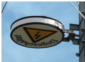
Abbildungen 13a und 13b: Schaltzeiger „Oberleitung des Ladegleises ist ausgeschaltet“
