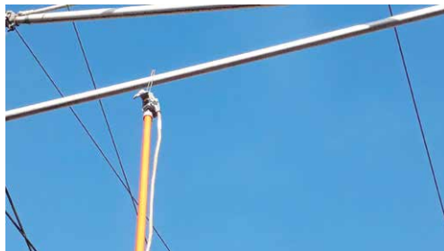
Abbildung 22: Feststellen der Spannungsfreiheit mit Prüfspitze
