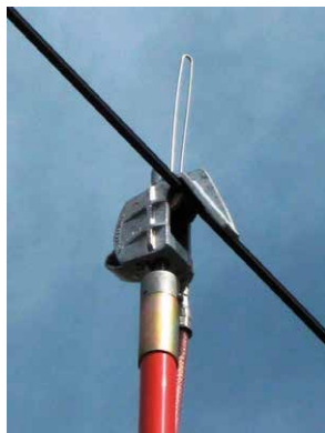
Abbildung 23: Einhängen der Fahrdrahterdungsklemme
