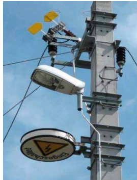
Abbildungen 18a, 18b und 18c: Schaltzeiger „Ausgeschaltet“/Stellscheiter „Erdung ein“
