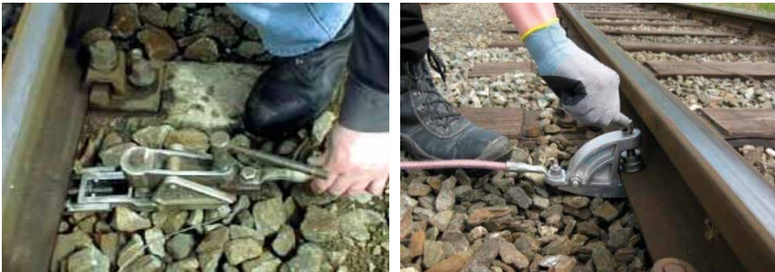
Abbildungen 20a und 20b: Befestigen der Schienenfußerdungsklemme
