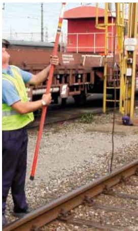
Abbildung 14c: Aufrichten der Erdungsstange
