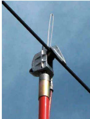
Abbildung 14f: Einhängen der Fahrradherdungsklemme
