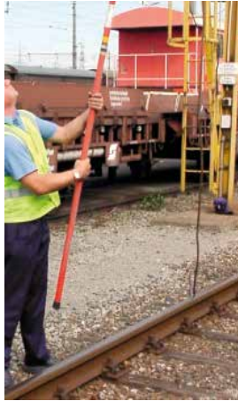
Abbildung 14c: Aufrichten der Erdungsstange
