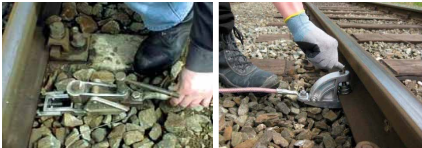
Abbildungen 14a und 14b: Befestigen der Schienenfußerdungsklemme
