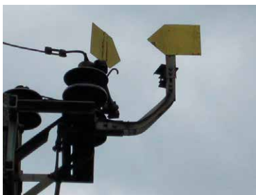
Abbildung 13b, 13c, 13d, 13e, 13f und 13g: Schaltzustand „eingeschaltet“: Schaltzeiger (Trommel) zeigt „eingeschaltet“, Stellungszeiger (2 gelbe Pfeile) zeigt „nicht geerdet“
