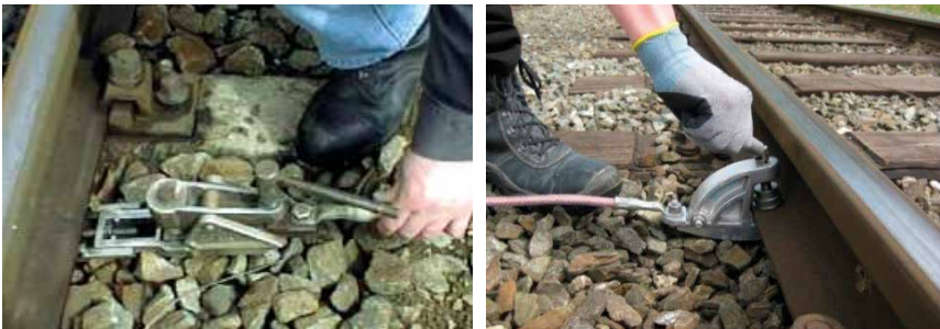
Abbildungen 14a und 14b: Befestigen der Schienenfußerdungsklemme
