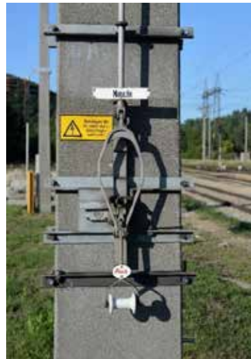
Abbildung 13a: Ladegleisschalter in Stellung „AUS“
