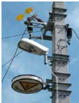
Abbildungen 13h, 13i und 13j: Schaltzustand „ausgeschaltet“: Schaltzeiger (Trommel) zeigt „ausgeschaltet“, Stellungszeiger (2 gelbe Pfeile) zeigt „geerdet“
