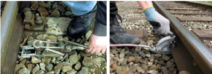
Abbildungen 14a und 14b: Befestigen der Schienenfußerdungsklemme
