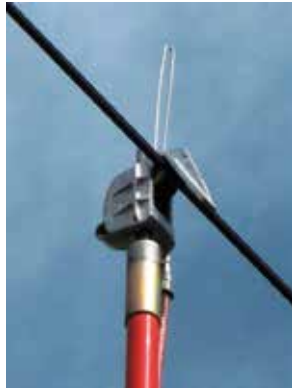
Abbildung 14f: Einhängen der Fahrdrähterdungsklemme
