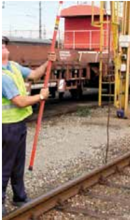
Abbildung 14c: Aufrichten der Erdungsstange
